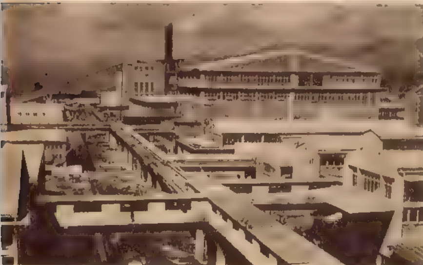
O parte din clădirile fabricii „Jugovinfi” din Split
